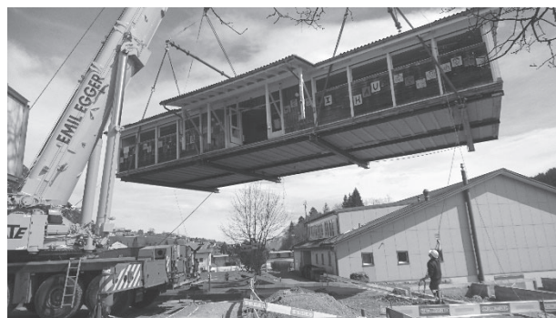
Versetzen des Pavillons
